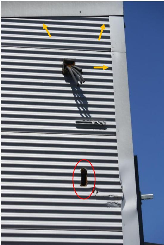
Abbildung 6. Wellblechverkleidung der Fassade mit Nischenstrukturen in den Randbereichen der Dach- und Eckabkantungen. Potenzielle Einflugöffnung rot umrandet
