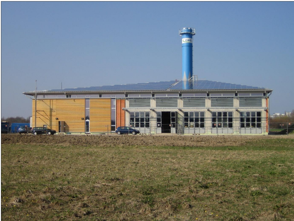
Abbildung 17: Geothermieheizzentrale Garching (Foto Stadt Garching, Mai 2011)
