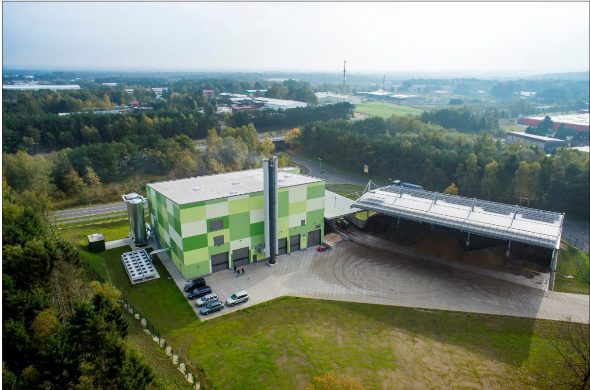
Abbildung 7: Beispiel BMHKW Lathen (Landkreis Emsland, Niedersachsen) – Feuerungswärmeleistung 2 – 5 MW, Wärmeerzeugung Heizkraftwerk: 32 MWh/a, Stromerzeugung ORC („Organic Rankine Cycle“): 8,7 Mio. kWh/a (aus: BioenergieDörfer - Leitfaden für eine praxisnahe Umsetzung)
